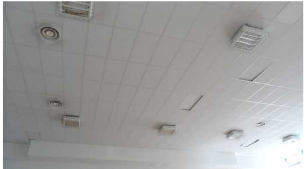
Spostamento dei pannelli di controsoffitto
