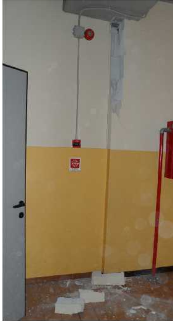
Distacco di intonaco
