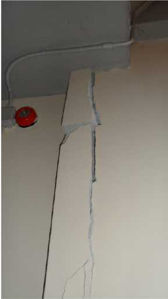
Distacco di intonaco
